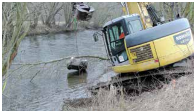
Damit das Totholz an den geplanten Stellen im Gewässer bleibt wird es vor dem Einbringen mit Steinen beschwert. (© G. Kemmler)
