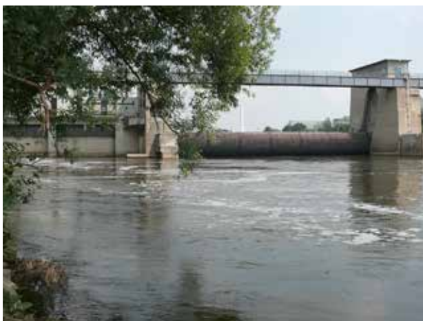
Wasserkraftanlage Offenbach (© S. Spahn / DAFV e.V.)
