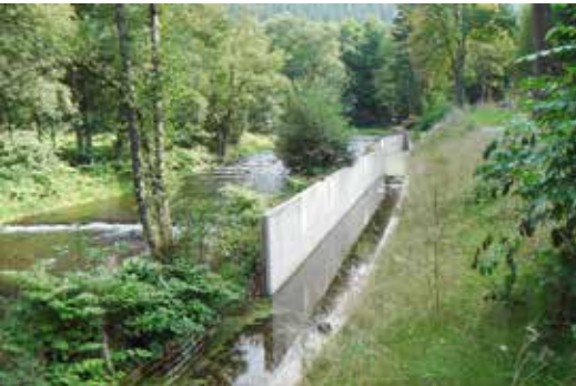
„Rothe Mühle“ NATURA 2000 Gebiet Schwarzatal, 650m Mühlgraben betoniert (© Gerhard Kemmler)
