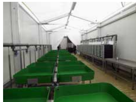
Innenansicht der neuen Bruthalle. (© Ackmann)
