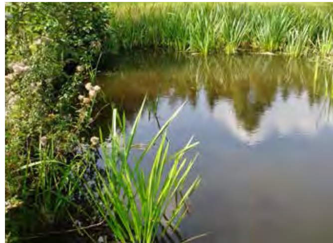
Ein Beispiel für einen naturnah geschaffenen Wasserrückhalteteraum durch Aufweitung und Vertiefung des Profils eines ehemaligen Wasserabzugsgrabens zu einem Grabenteich. Neue Biotope für bestandsgefährdete Pflanzen- und Tierarten werden geschaffen, ebenso neue Fischhabitats. Durch den Wasserrückhalt wird weiterhin ein wesentlicher Beitrag zur Eindämmung von Hochwasserschäden geleistet. (© Erich Koch)
