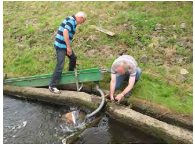
D. Labrenz und K. Marzian bei der Montage einer Aalleiter
