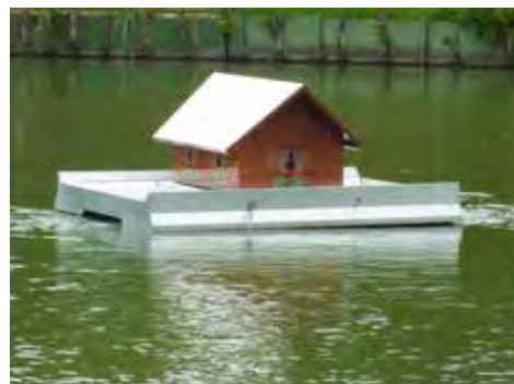
Netzbetriebene Anlage, Grundkörper und Aufbauten komplett aus Edelstahl (EKS Archiv)
