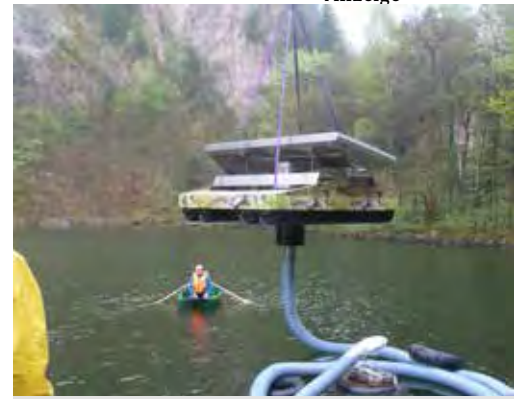
Solaranlage mit einem an die Umgebung angepassten Design (EKS Archiv)
