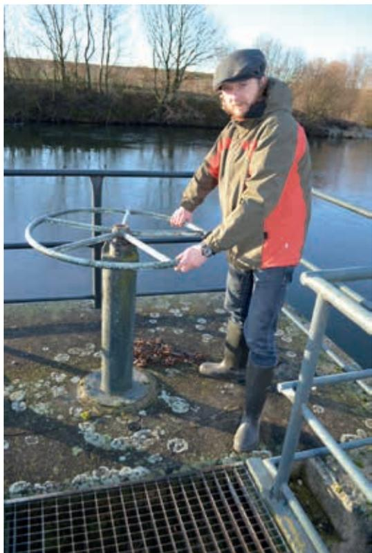
Funktionsprüfung des am Schieber
