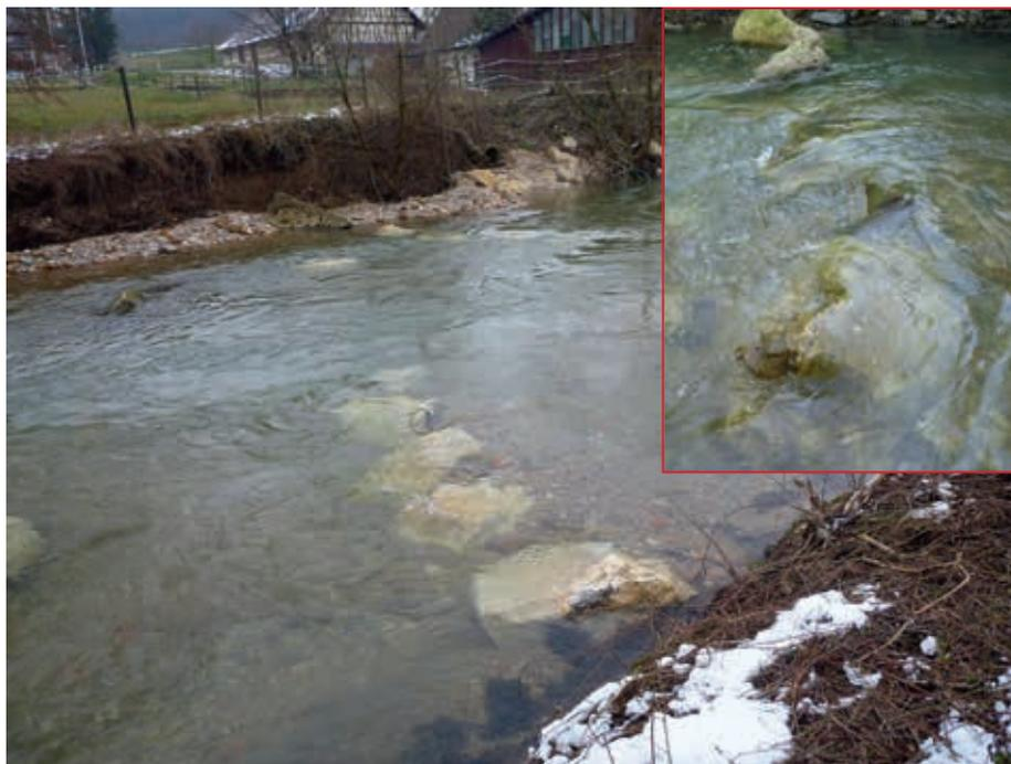
Bei den Renaturierungsmaßnahmen der Lauter wurden Störsteine eingesetzt sowie mit Hilfe von Flussbausteinen Lenkbuhnen geschaffen, deren sekundäre Querströmungen bei Hochwasser einen gewölbten Strömungszopf zur Strommitte bilden.
